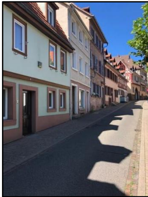
Abb. 7: Traufständige Gebäude in der Mittelgasse
