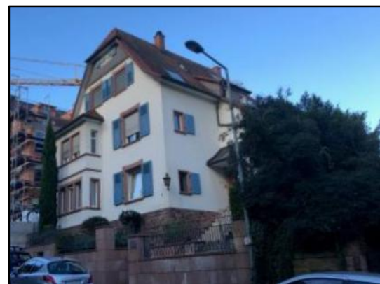
Abb. 8: Giebelständiges Gebäude in der Ehretstraße
