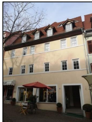
Abb. 39: Gebäude mit Fensterbankgesims
