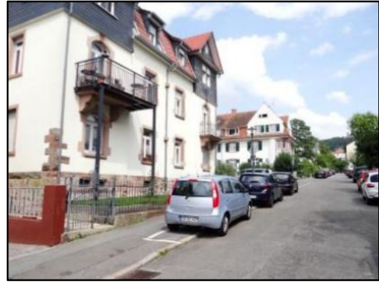
Abb. 45: Sockel aus Bruchstein und Faschen aus Buntsandstein
