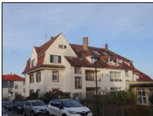
Abb. 25: Mansarddach mit Satteldach
