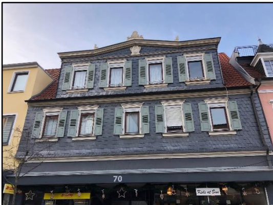
Abb. 26: Typische Fensterformate im Erhaltungsgebiet
