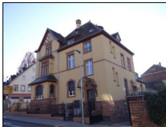
Abb. 37: Sockel, Faschen und Gesims aus Naturstein
