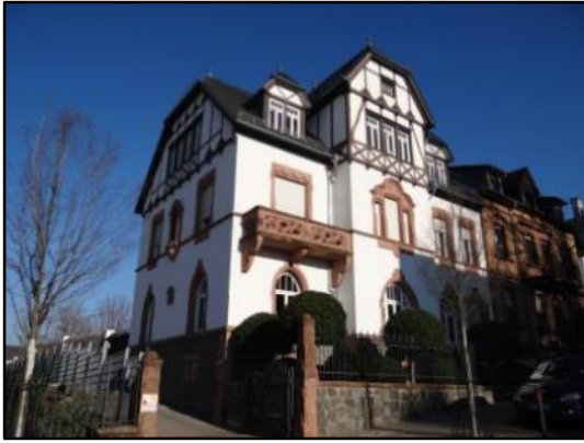
Abb. 44: Faschen und Gesims aus Buntsandstein
