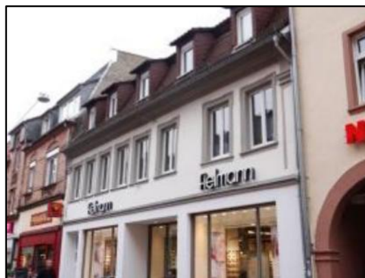
Abb. 30: Gebäude mit Gurtgesims
