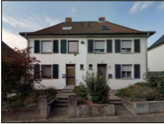
Abb. 31: Horizontale und vertikale Gliederung bei einem traufständigen Gebäude in der Prankelstraße
