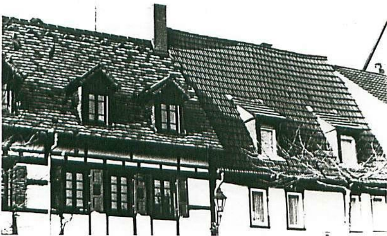
Beispiele für Giebel- und SchlepPGAuben
