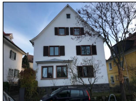
Abb. 9: Giebelständiges Gebäude in der Karrillonstraße
