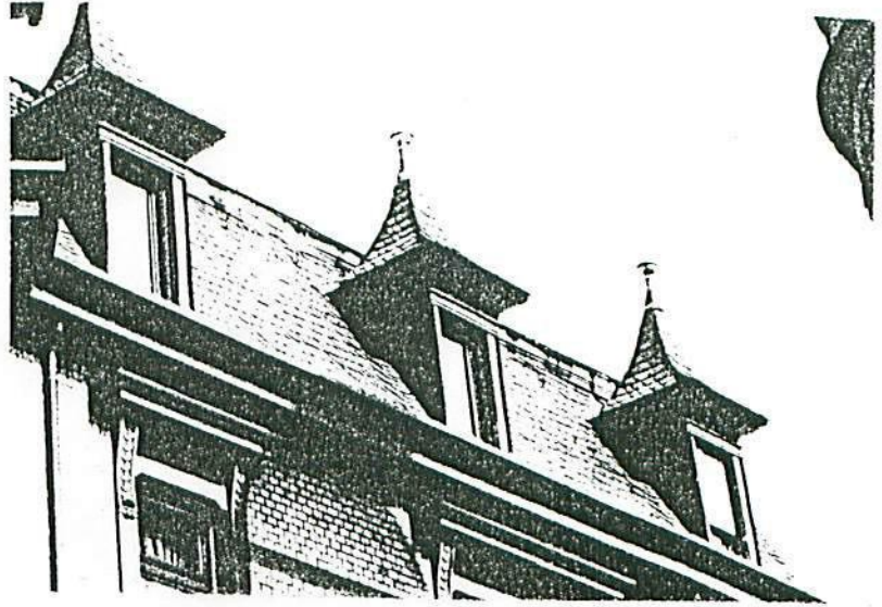
Sonderform von Dachgauben aus der Gründerzeit, die sich ebenfalls einfügt
