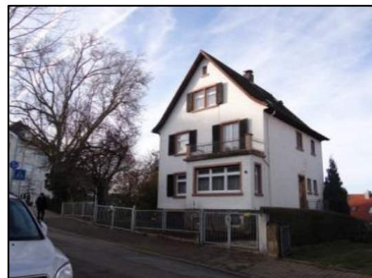
Abb. 8: Giebelständiges Gebäude in der Albert-Ludwig-Grimm-Straße
