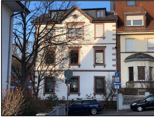
Abb.31: Horizontale und vertikale Gliederung bei einem traufständigen Gebäude in der Hildastraße
