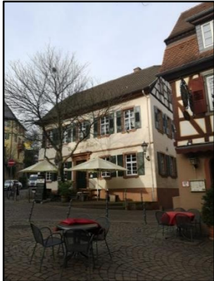
Abb. 22: Horizontale und vertikale Gliederung bei einem traufständigen Gebäude
