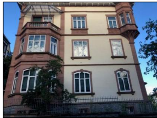
Abb.39: Gebäude mit Gurt- und Sockelgesims
