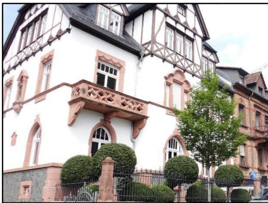
Abb. 38: Gebäude mit Sockel- und Fensterbankgesims
