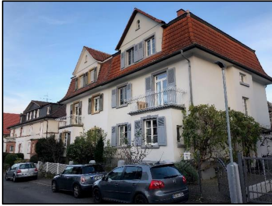
Abb. 13: Ausbau des Dachgeschosses in der Bissingerstraße
