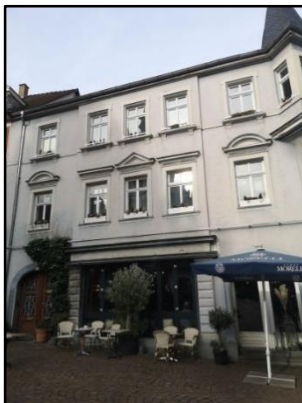
Abb. 38: Gebäude mit Fensterbank- und Gurtgesims
