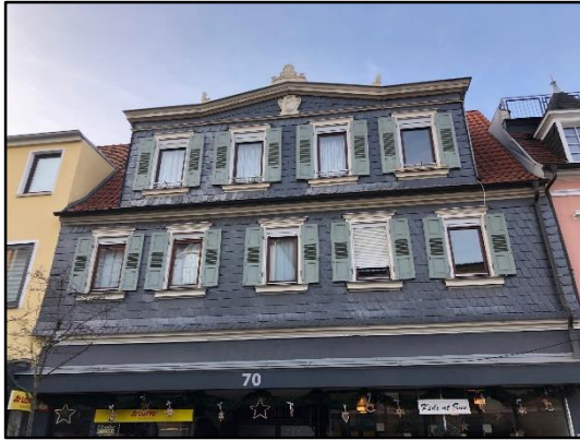
Abb. 26: Typische Fensterformate im Erhaltungsbereich
