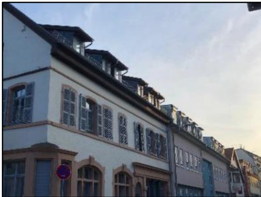
Abb. 19: Schleppgaube
