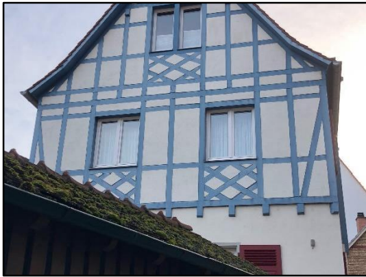
Abb.30: Fenster mit Flügelteilung
