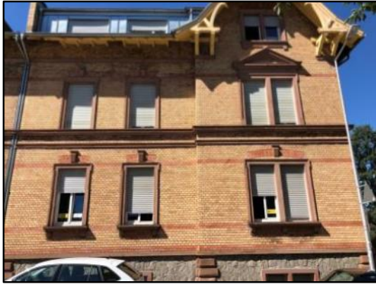
Abb. 39: Gebäude mit Sockel-, Gurt- und Fensterbankgesims
