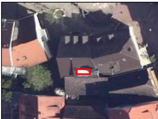
Abb. 4: Dacheinschnitt in der Institutstraße (rote Umrandung)
