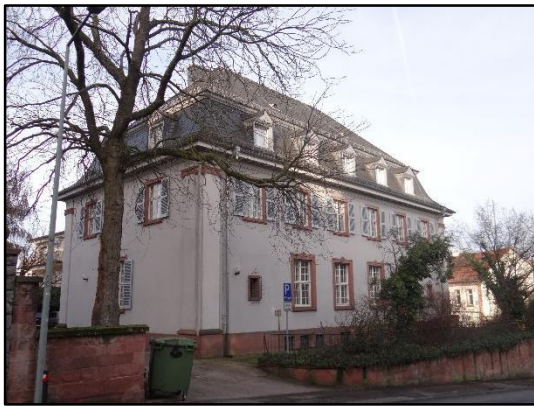
Abb. 21: Mansarddach mit Walmdach
