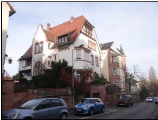
Abb. 23: Krüppelwalmdach
