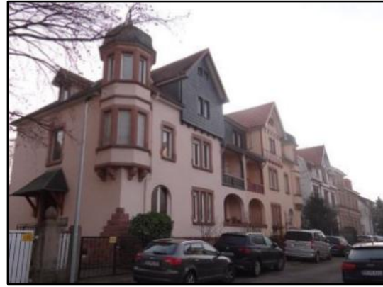
Abb.16: Gebäude mit Runderker in der Hildastraße
