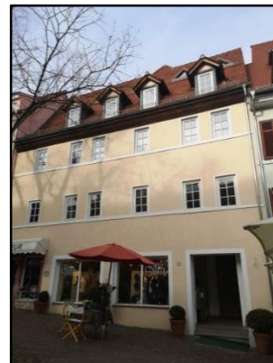
Abb. 39: Gebäude mit Fensterbankgesims
