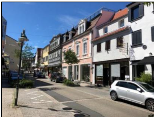
Abb. 7: Traufständige Gebäude in der Hauptstraße
