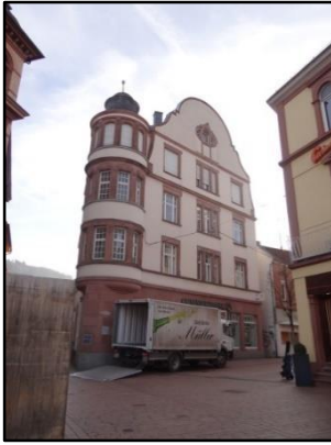
Abb. 29: Gebäude mit Gurt- und Fensterbankgesims
