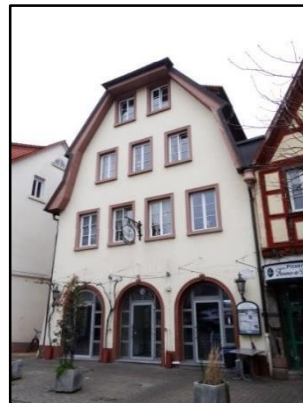
Abb. 8: Giebelständige Gebäude in der Hauptstraße
