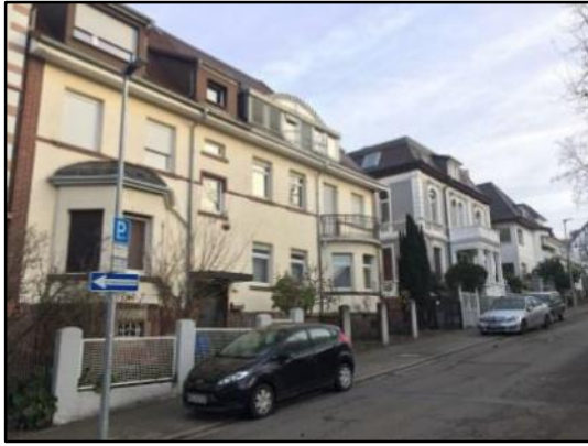
Abb.15: Gebäude mit Auslucht in der Moltkestraße
