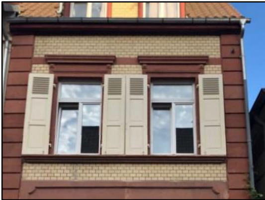
Abb. 27 und 28: Fensterläden im Erhaltungsbereich
