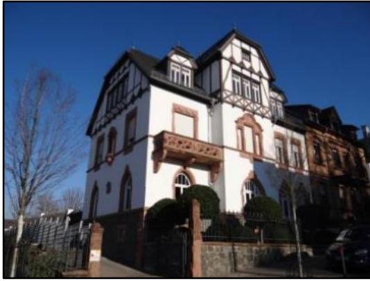
Abb. 40: Faschen und Gesims aus Buntsandstein
