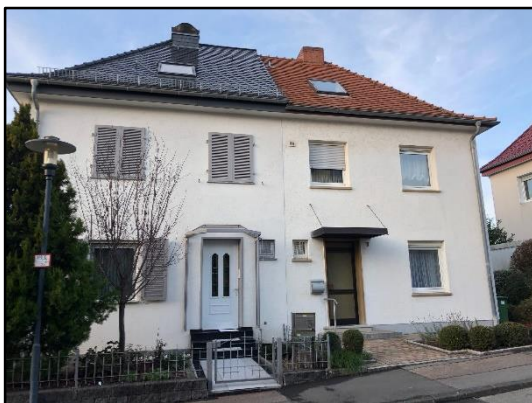
Abb. 8: Traufständige Gebäude in der Bodestraße
