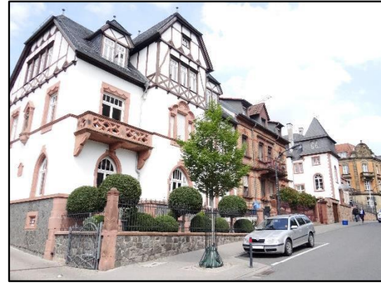
Abb. 10: Gebäude mit vorgegarterm Gartenbereich und Stützmauer
