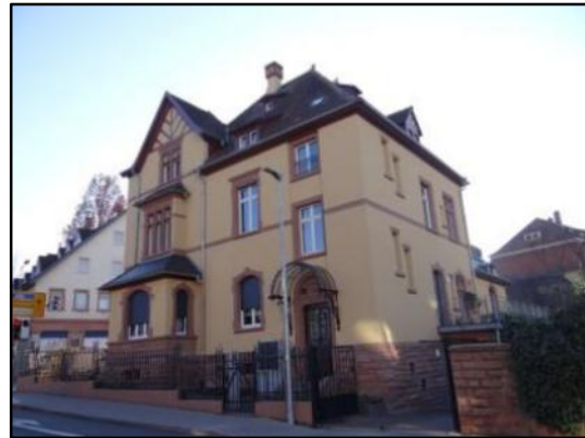
Abb. 37: Sockel, Faschen und Gesims aus Naturstein
