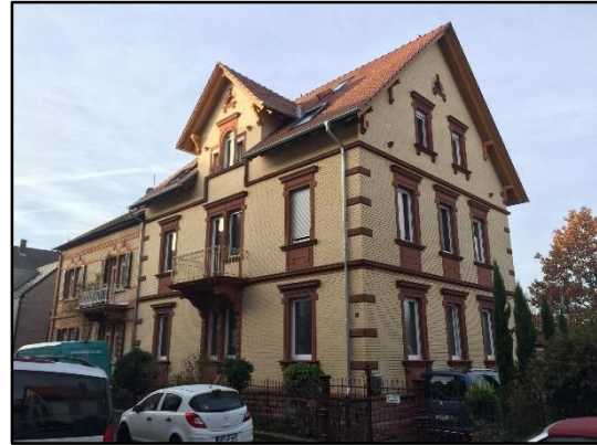
Abb.40: Gebäude mit Gurtgesims
