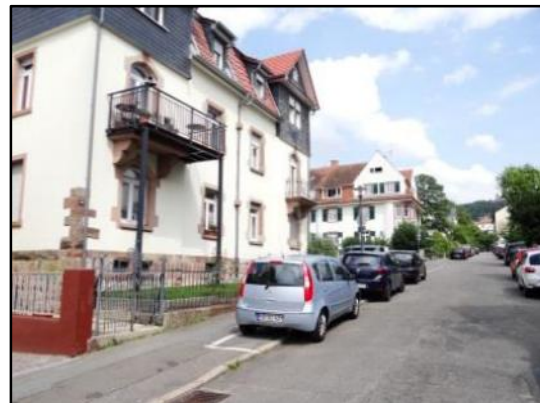
Abb. 42: Sockel aus Bruchstein und Faschen aus Buntsandstein
