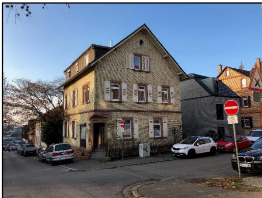
Abb. 41: Faschen und Gesims aus Buntsandstein
