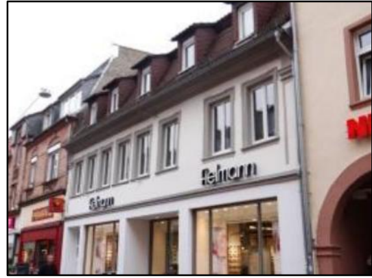
Abb. 30: Gebäude mit Gurtgesims
