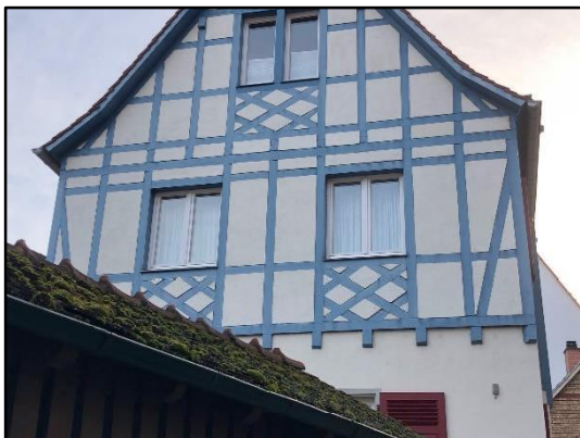
Abb.30: Fenster mit Flügelteilung
