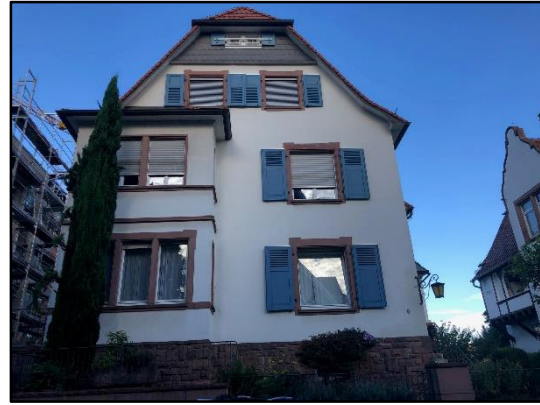
Abb. 41: Sockel aus Bruchstein und Faschen aus Buntsandstein
