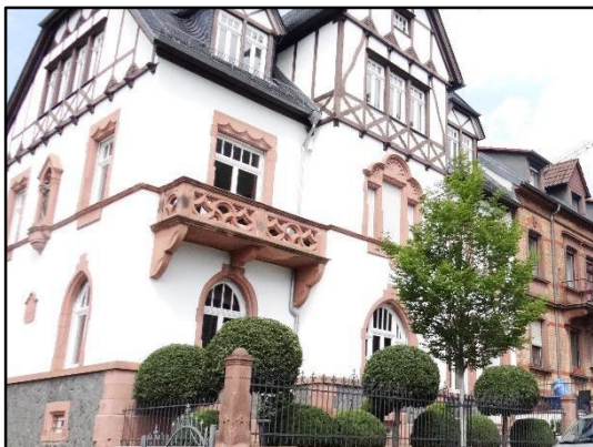
Abb. 38: Gebäude mit Sockel- und Fensterbankgesims
