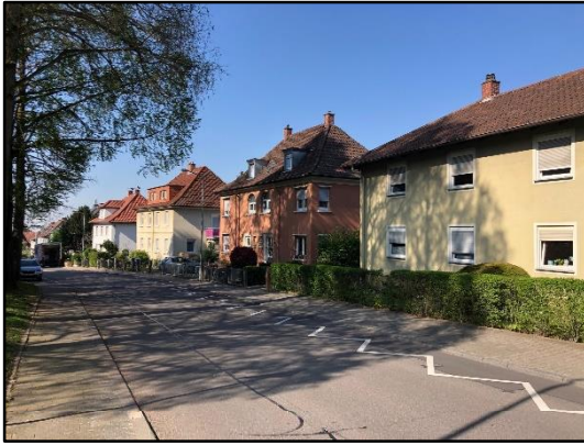
Abb. 8: Traufständige Gebäude in der Prankelstraße
