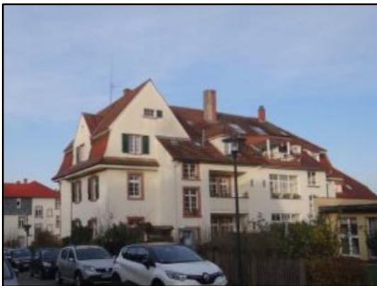
Abb. 22: Mansarddach mit Satteldach
