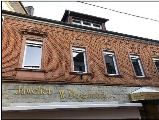
Abb. 25: Typische Fensterformate im Erhaltungsgebiet
