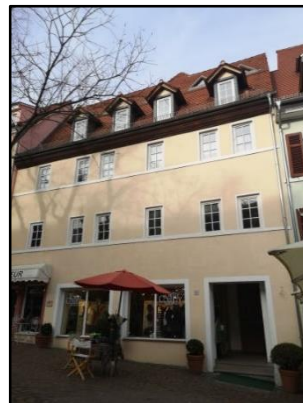
Abb. 39: Gebäude mit Fensterbankgesims
