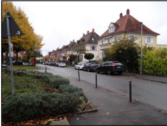
Abb. 12: Ausbau des Dachgeschosses in der Bissingerstraße
