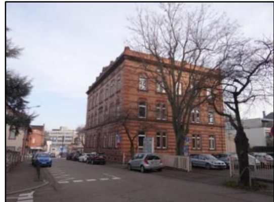
Abb.13: Öffentliche Einrichtungen, die aus der typischen Bebauung herausstechen (hier: ehemalige Diesterwegschule (heutige Stadtbibliothek) in der Schulstraße)
