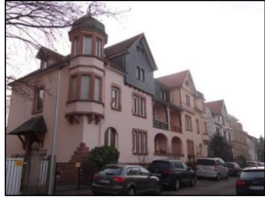
Abb.17: Gebäude mit Runderker in der Hildastraße
