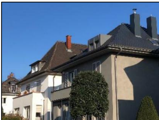
Abb. 22: Flachdachgaube
