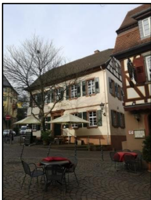
Abb. 22: Horizontale und vertikale Gliederung bei einem Schemaskizze traufständigen Gebäude in der Institutstraße
