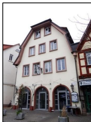
Abb. 8: Giebelständige Gebäude in der Hauptstraße
