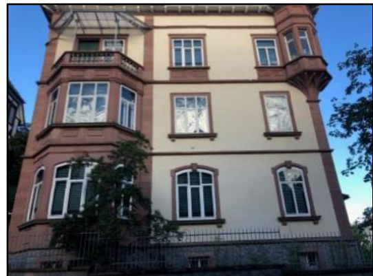
Abb.43: Gebäude mit Gurt- und Sockelgesims
