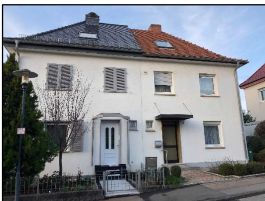
Abb. 7: Traufständige Gebäude in der Bodestraße
