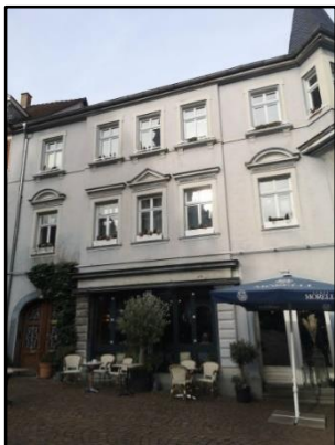
Abb. 38: Gebäude mit Fensterbank- und Gurtgesims
