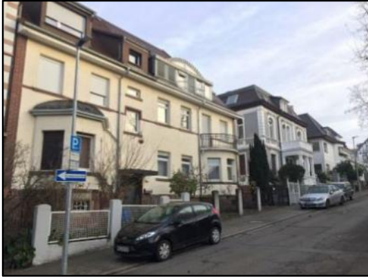
Abb.16: Gebäude mit Auslucht in der Moltkestraße
