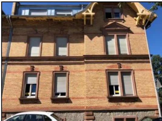
Abb. 42: Gebäude mit Sockel-, Gurt- und Fensterbankgesims
