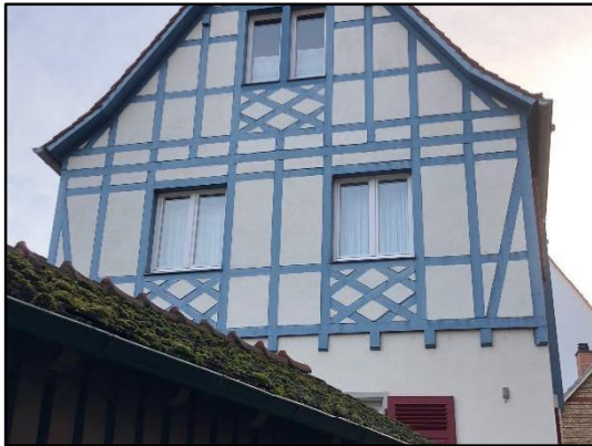
Abb.30: Fenster mit Flügelteilung
