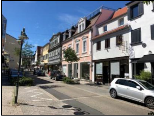
Abb. 7: Traufständige Gebäude in der Hauptstraße
