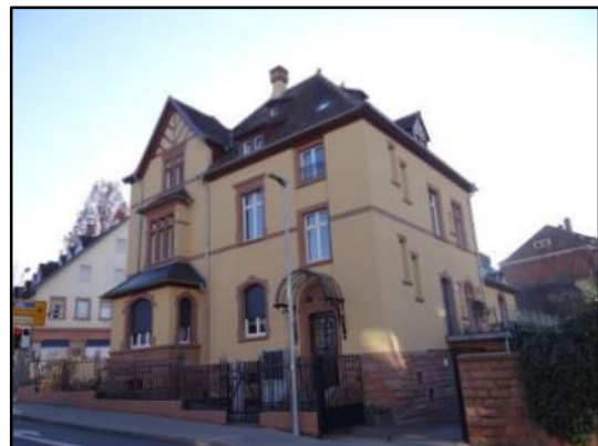
Abb. 37: Sockel, Faschen und Gesims aus Naturstein
