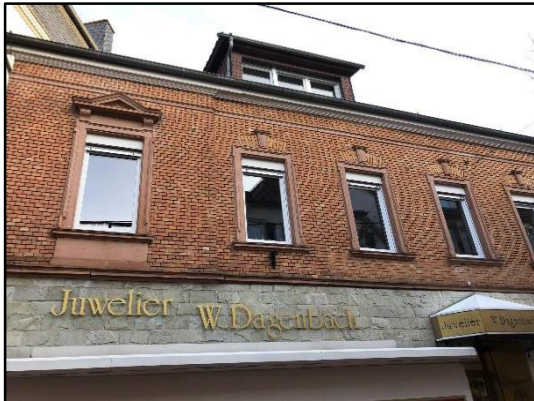
Abb. 25: Typische Fensterformate im Erhaltungsbereich
