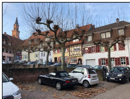
Abb. 13: Bebauung, die sich am Gelände orientiert (Blickrichtung Nordwesten)
