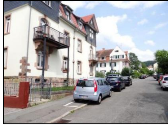
Abb. 45: Sockel aus Bruchstein und Faschen aus Buntsandstein
