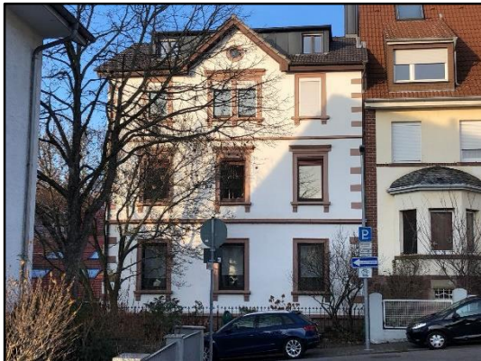
Abb.34: Horizontale und vertikale Gliederung bei einem traufständigen Gebäude in der Hildastraße
