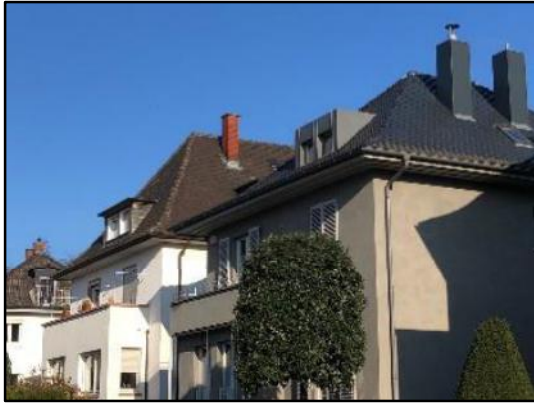
Abb. 22: Flachdachgaube
