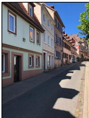
Abb. 7: Traufständige Gebäude in der Mittelgasse
