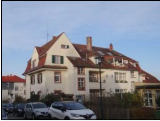
Abb. 25: Mansarddach mit Satteldach
