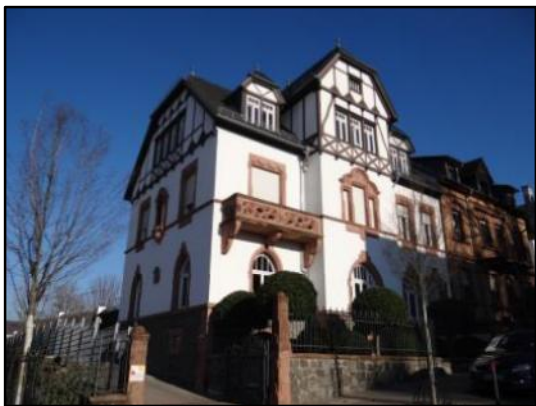
Abb. 44: Faschen und Gesims aus Buntsandstein
