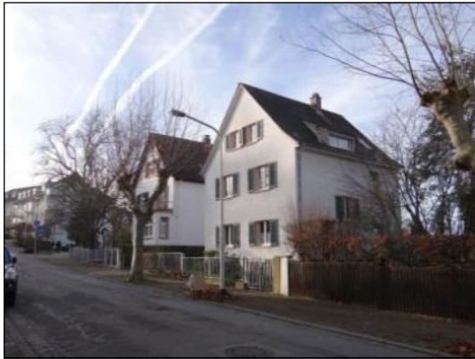
Abb. 26: Horizontale und vertikale Gliederung bei einem giebelständigen Gebäude in der Albert-Ludwig-Grimm-Straße
