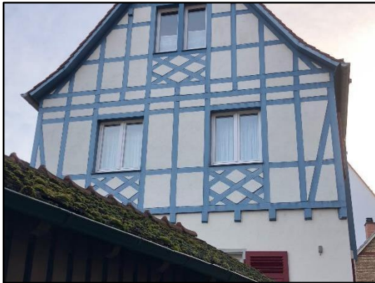
Abb.30: Fenster mit Flügelteilung
