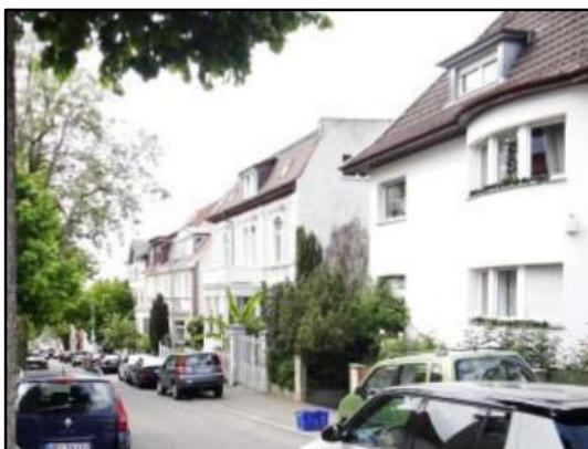
Abb. 7: Traufständige Gebäude in der Moltkestraße
