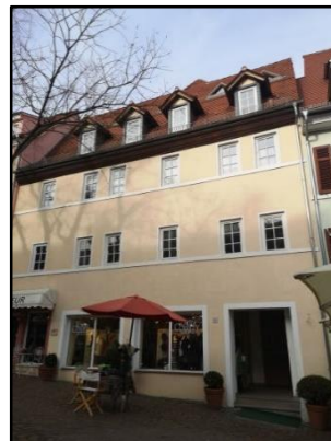
Abb. 39: Gebäude mit Fensterbankgesims
