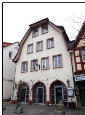
Abb. 8: Giebelständige Gebäude in der Hauptstraße
