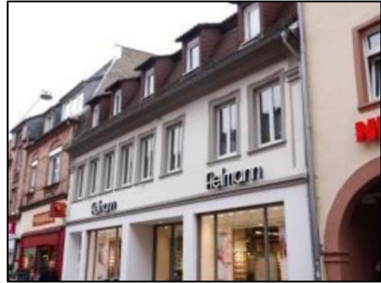
Abb. 30: Gebäude mit Gurtgesims
