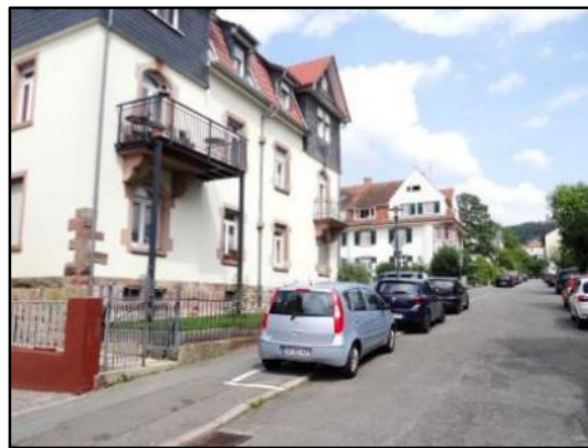
Abb. 45: Sockel aus Bruchstein und Faschen aus Buntsandstein
