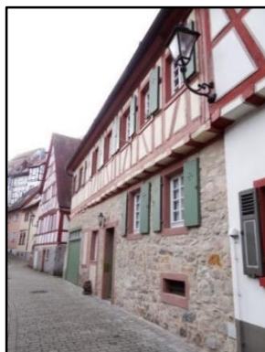
Abb. 26 und 27: Gebäude mit gemauertem Erdgeschoss und Fachwerk im Obergeschoss
