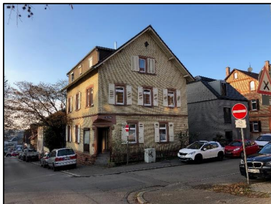
Abb.36: Horizontale und vertikale Gliederung bei einem giebelständigen Gebäude in der Sophienstraße
