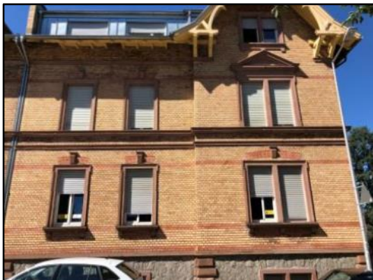
Abb. 42: Gebäude mit Sockel-, Gurt- und Fensterbankgesims
