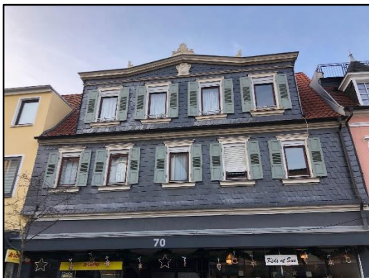
Abb. 26: Typische Fensterformate im Erhaltungsgebiet
