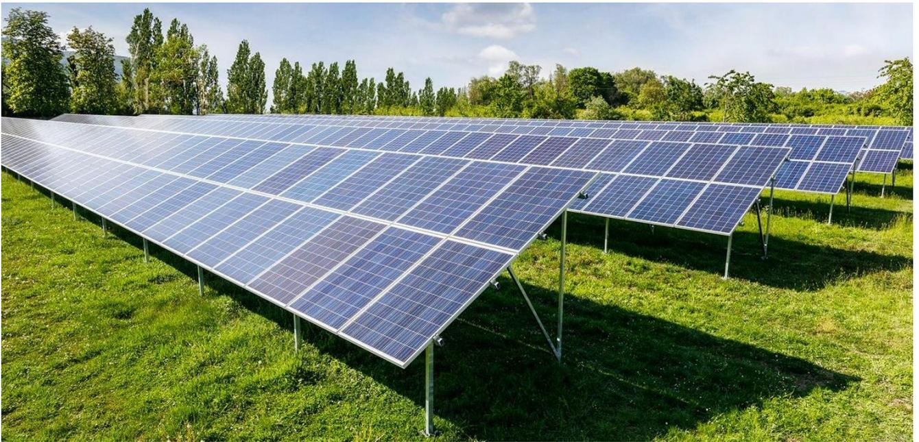
**Abb. 1: Konventionelle Freiflächen-Photovoltaikanlage**
