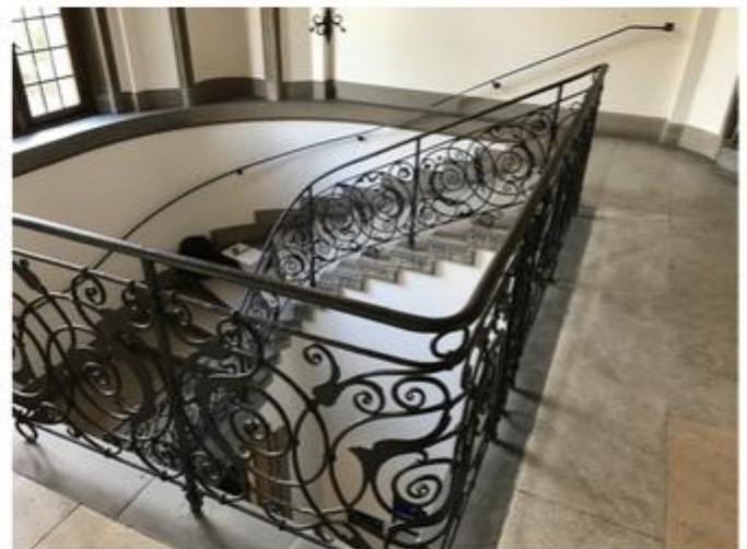
3. Lauf - 1. Zwischenpodest bis Austritt 1. OG, 14 Steigungen
