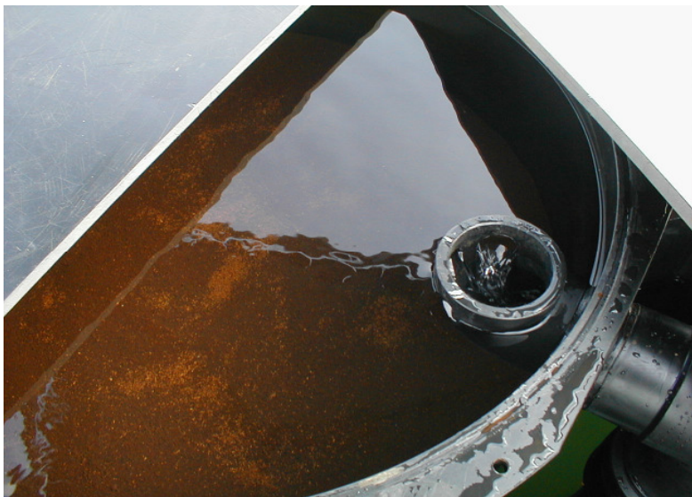
Abb. 7: Blick in den Filterbehälter: Adsorbergranulat und Rücklauf des entphosphateten Wassers
