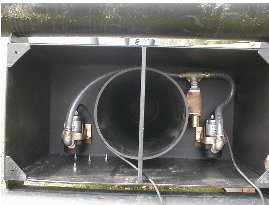
Abb.6: Solar-Förderpumpen im Beimodul
