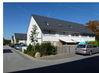
Reihenhausbebauung an der Körnerstraße
