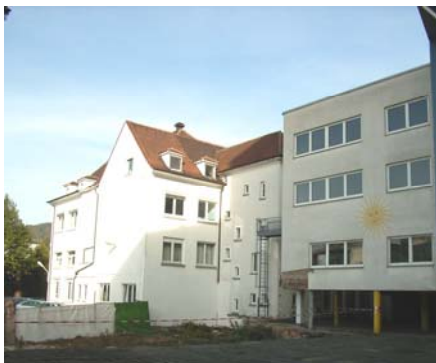
Abbildung 7: Blick auf Bau 17 und 10
