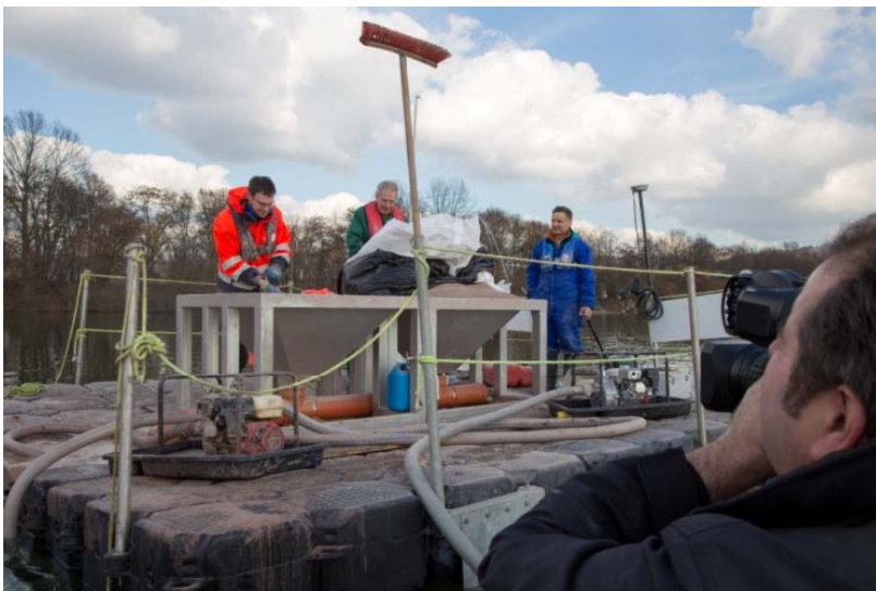
Foto 7: Dreharbeiten des SWR während der Arbeiten
