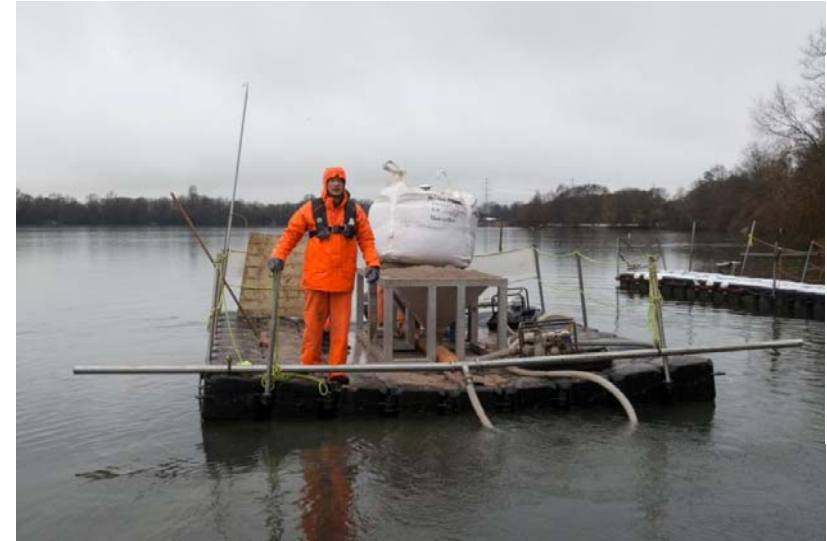
Foto 6: Arbeitsplattform; im Vordergrund der Applikationsbalken
