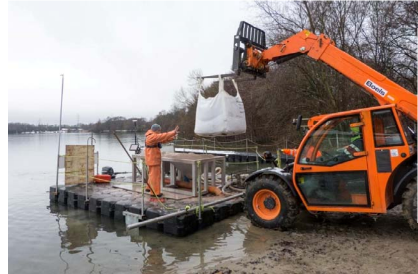
Foto 2: Beladen der Arbeitsplattform mit 1,05 to - BigBags Bentophos
