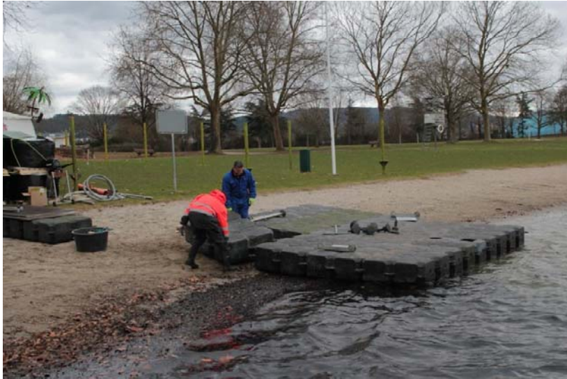
Foto 1: Aufbau der Arbeitsplattform am Ufer des Strandbads
